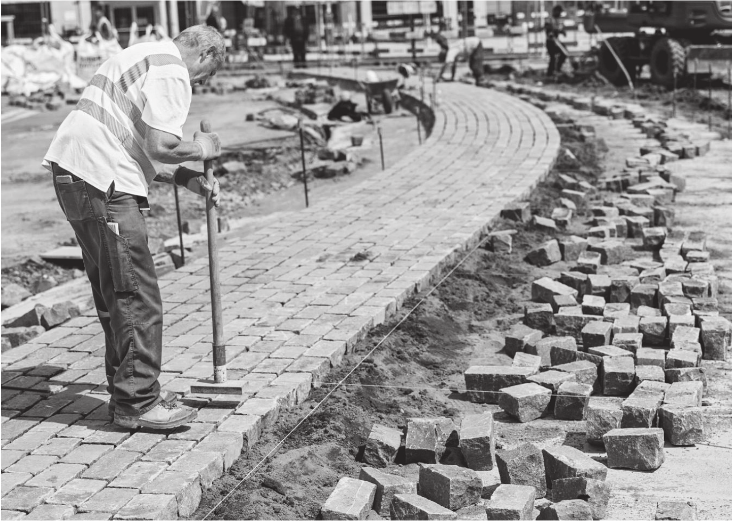
Roland Verboux, patron de l'entreprise mandatée, utilise une dame à main afin de garantir une surface parfaitement plane. OLIVIER VOGELSANG
